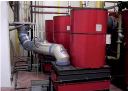
安装实例: 3 台 ThermoCondensator aluFer® (1100) 位于 Fussach (奥地利) 的 Julius Blum 有限公司.
